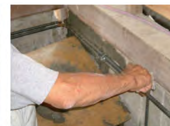
コンクリート下塗り
