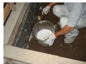
プライマー塗り
