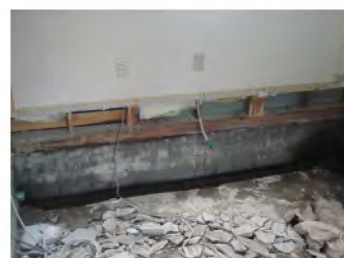
既存基礎の清掃
