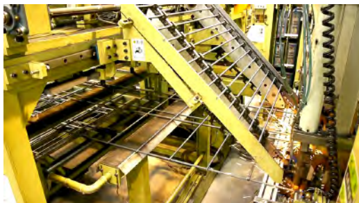
溶接工程 (鉄筋自動供給装置)
